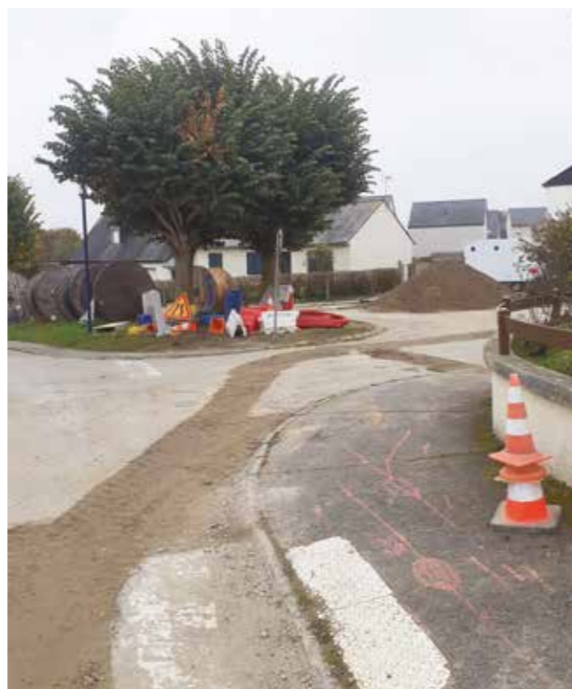
Réhabilitation des réseaux dans la rue des Hortensias
